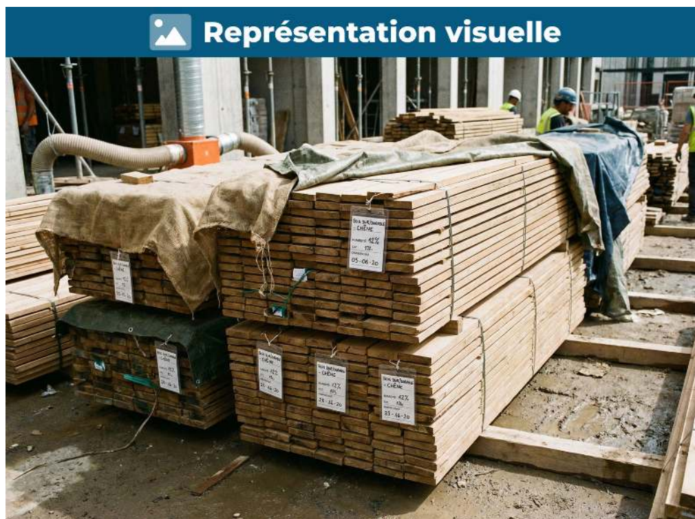
Stockage des lattes à l'abri avec ventilation pour éviter l'humidité
